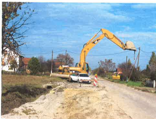
Slika 18 Izgradnja kolektorskog sustava na južnoj periferiji Rugvice
