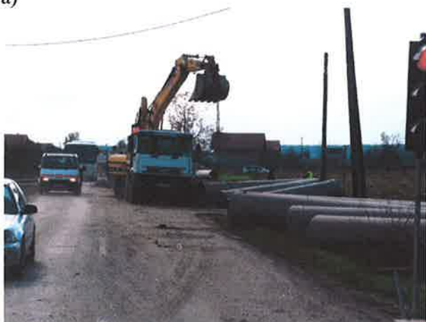
Slika 14 Radovi na izgradnji kanalizacionog sustava uz cestu Rugvica-Oborovo (snimljeno 23.X.2011.)
