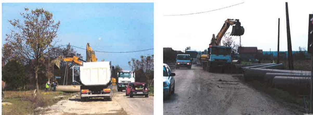
Slika 4 Radovi na izgradnji kanalizacijskog sustava (u južnom dijelu Rugvice). Snimljeno 22.X.2010.
